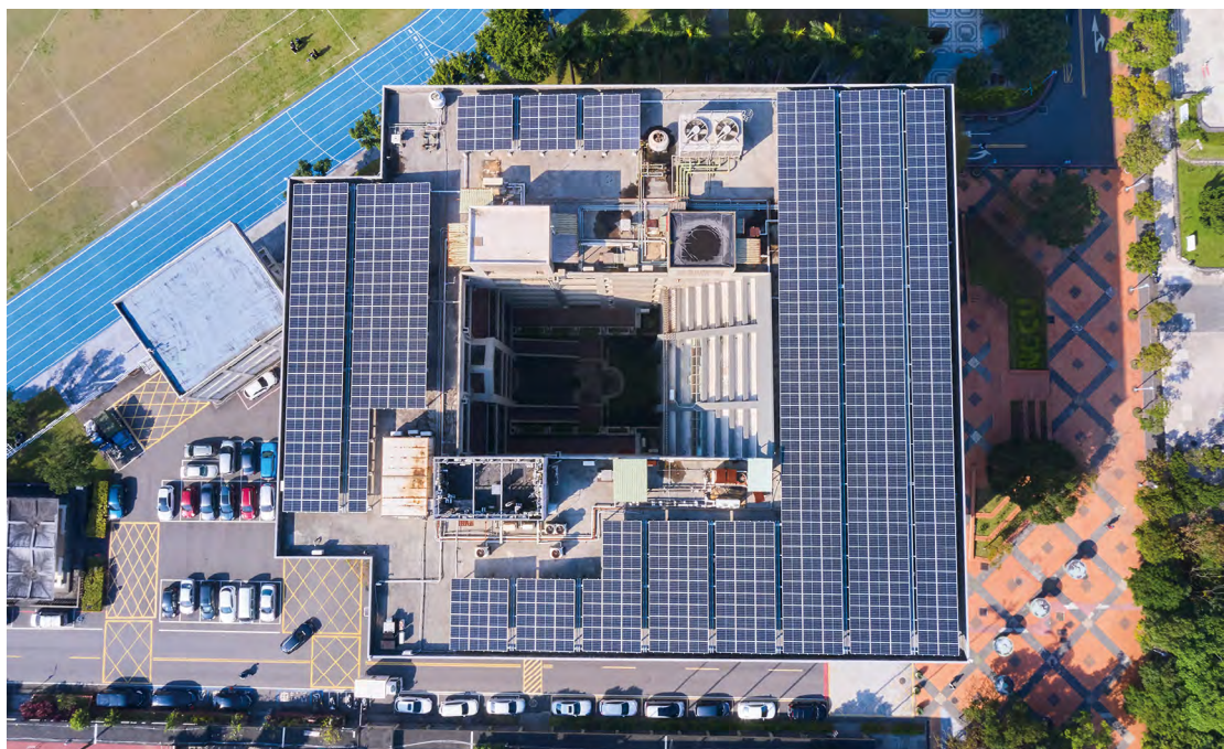
行政大樓頂樓太陽能面板已建置完成，逐步推動減碳和再生能源，實現永續校園的目標（攝影：秘書處）
